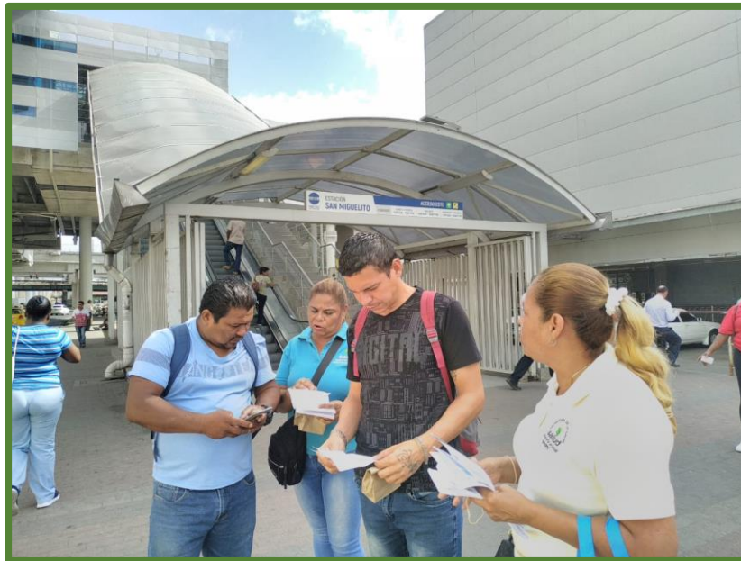
Estación del Metro de San Miguelito
